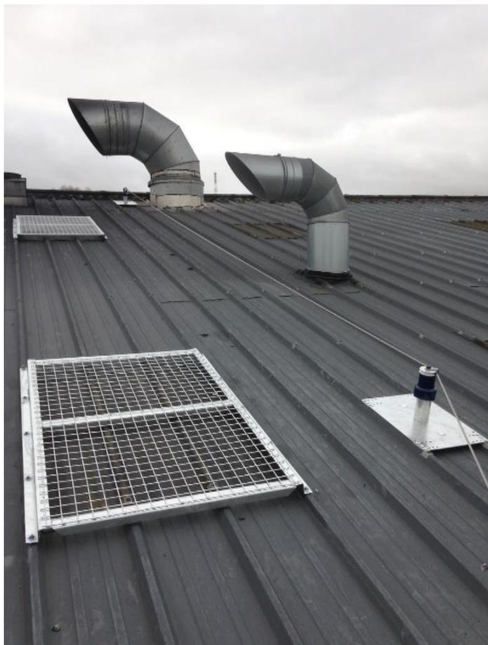
Selon la **recommandation MR72**, les tests à 1200 Joules sont réalisés par l'intermédiaire d'une masse de 50kg lâché à 2.4m au-dessus de la grille de protection pour translucide. La charge doit être retenue après impact. Les grilles antichutes étant sur-mesure, les essais sont réalisés pour chaque dossier sur la grille présentant mécaniquement le moins de résistance. (si aucun essai similaire n'a été réalisé précédemment).
